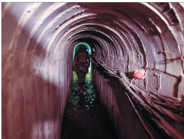
Einer der HAMAS Tunnel in Gaza / Один из туннелей ХАМАСа в Газе
